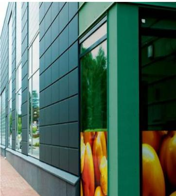
Сталь с покрытием PVDF Matt — результат совместной работы Компании Металл Профиль и «Ruukki» (Финляндия) — стали с полимерным покрытием для изготовления фасадных систем PVDF Matt (матовый PVDF).
